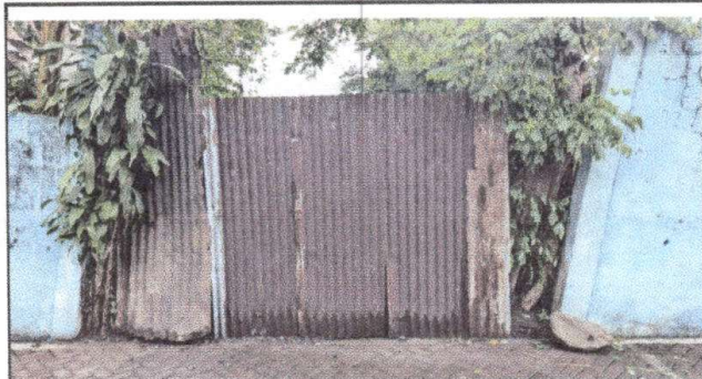
Foto 4: Portón de lámina, que se usa como segundo acceso.
